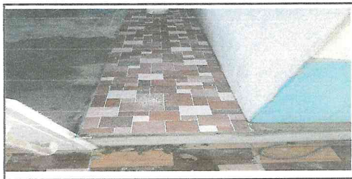
INSTALACIÓN DE PISO CERAMICO EN EL AREA DE LA COCINA
