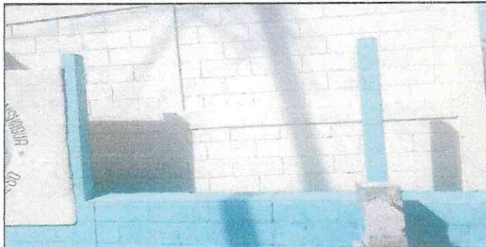
DESISTALACIÓN DE MALLA DEL MURO PERIMETRAL
