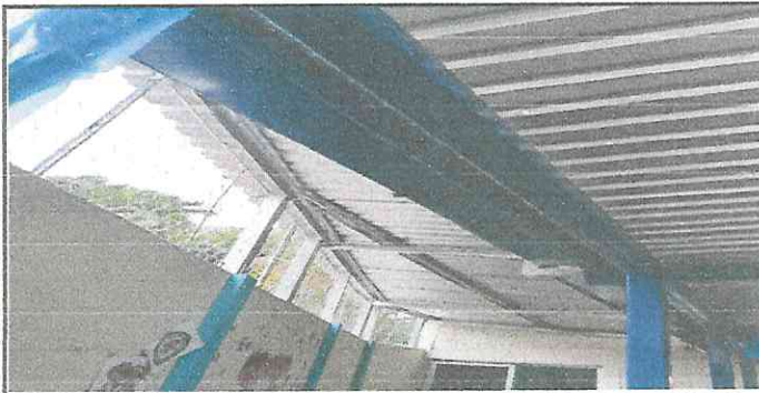
INSTALACIÓN DE TECHO EN AREA DEL PATIO
