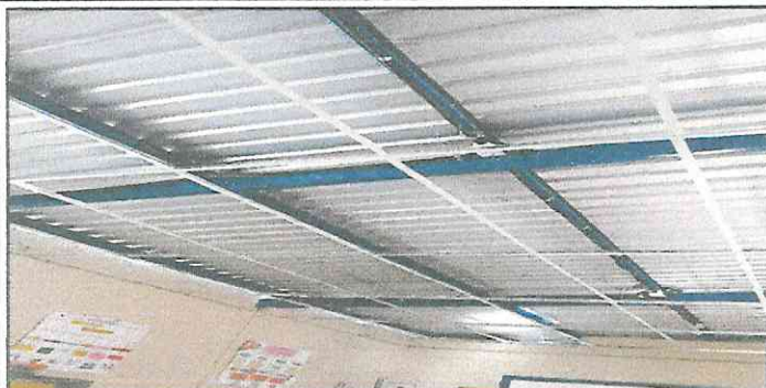
PROCESO DE INSTALACION DE CIELO FALSO EN AULA 1 Y 2
