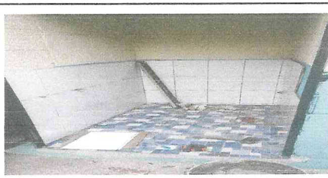
PROCESO DE INSTACIÓN DE PISO CERAMICO Y AZULEJO EN EL AREA DE LOS SANITARIOS
