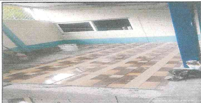
INSTALACIÓN DE PISO CERAMICO EN EL AREA DEL ECENEARIO
